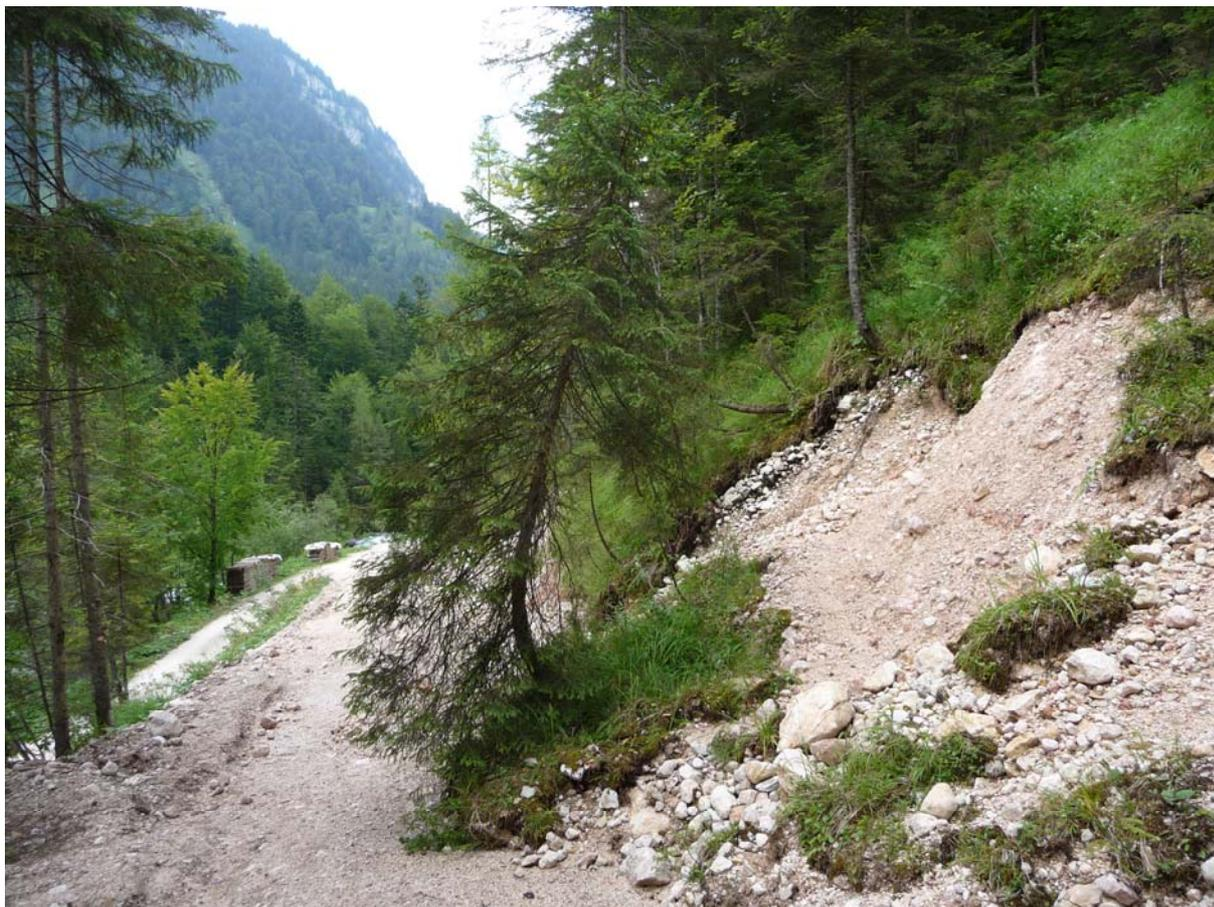
Abbildung 27: Erosion durch den Neubau von Forststraßen bei den Klausbrunnquellen
