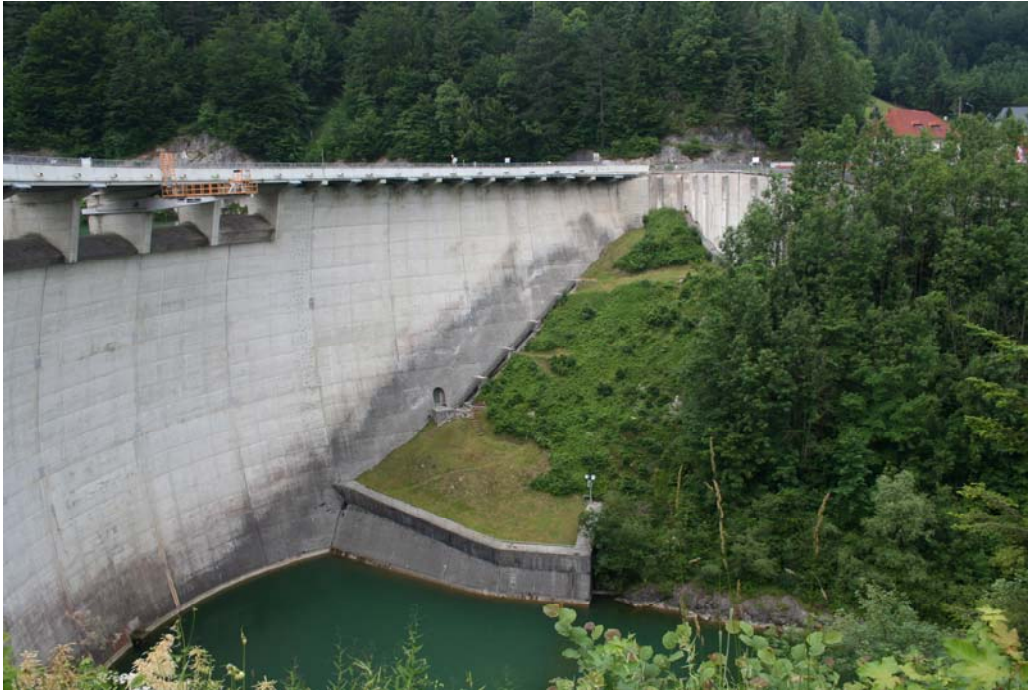
Abbildung 57: Staumauer in Klaus mit Uferverbauungen
