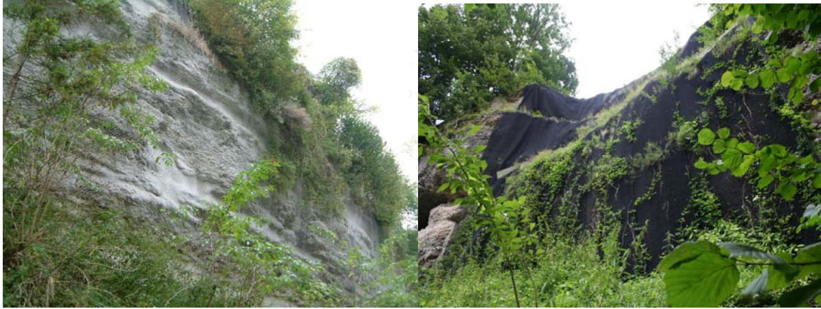
Abbildung 35: Befestigte Konglomeratwände: links mit Flüssigbeton und Gitter (Gem. Grünburg, Biotop129); rechts mit Matten (Gem. Steinbach, Biotop 131)
