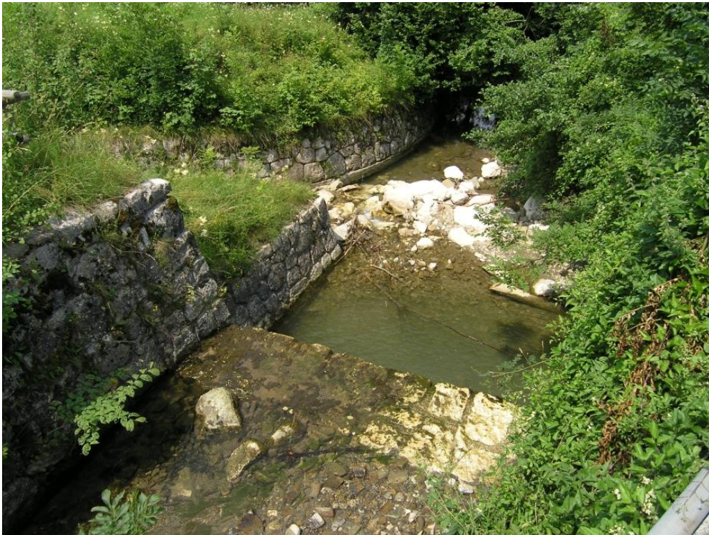
Abbildung 41: Harte Bachverbauung im Übergangsbereich offene Landschaft – Siedlungsraum in Kasten (B. Thurner).
