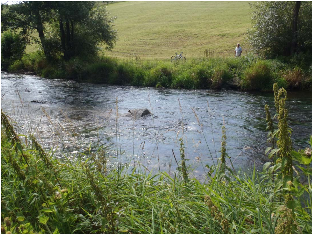
Abbildung 10. Zustand nach Fertigstellung der Restrukturierung mit bereits deutlichem Einfluss auf die Fließgewässerhydraulik bei Mittelwasser (Zunahme der Strömungsvariabilität im Vergleich zu Abbildung 9).
