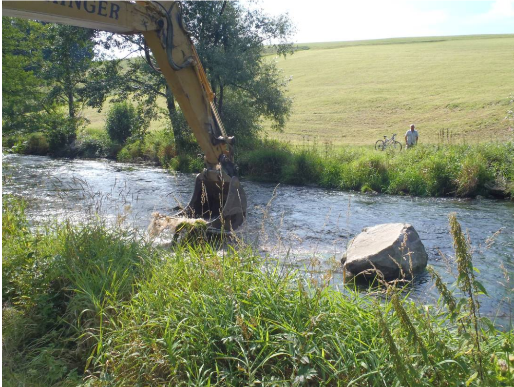
Abbildung 9. Abnahme der Deckschicht in der Pilotstrecke 1 (Bruckhäuser).
