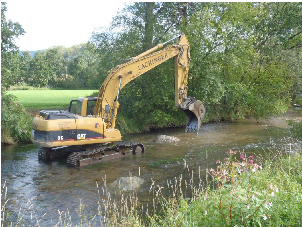
Abbildung 12. Positionierung eines Granitblocks in der Untersuchungsstrecke 2 (Bruckmühle).
