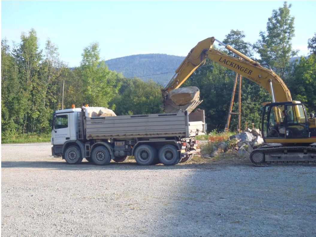
Abbildung 7. Verladung der Granitblöcke mittels 24-Tonnen Bagger auf einen 4-achsigen Spezialtransporter.
