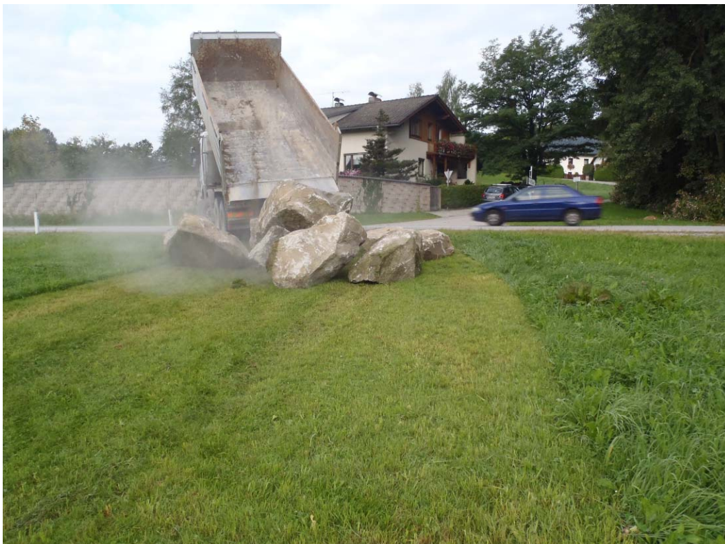
Abbildung 8. Abladen der transportierten Blöcke ( n = 6 ) an der Versuchstrecke 3 im Bereich von Haslach. Um den Flurschaden gering zu halten wurden vor der Maßnahmenumsetzung Teile des Grünlandes gemäht.
