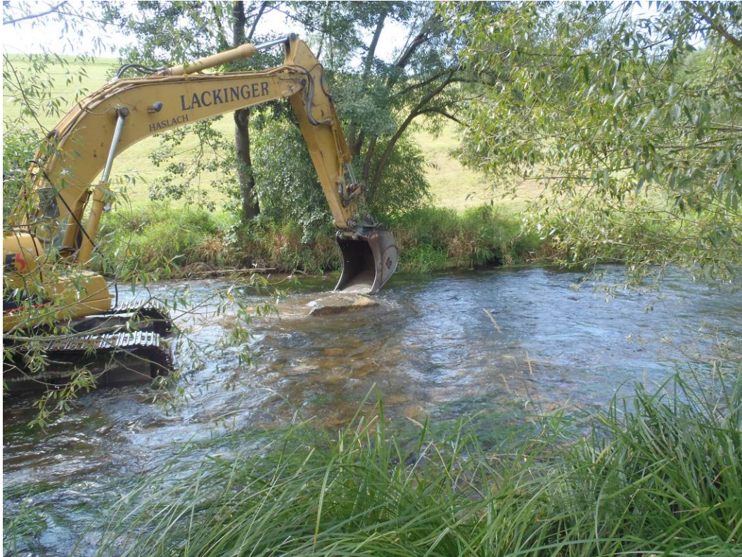
Abbildung 11. Positionierung eines Granitblocks in der Untersuchungsstrecke 1 (Bruckhäuser).
