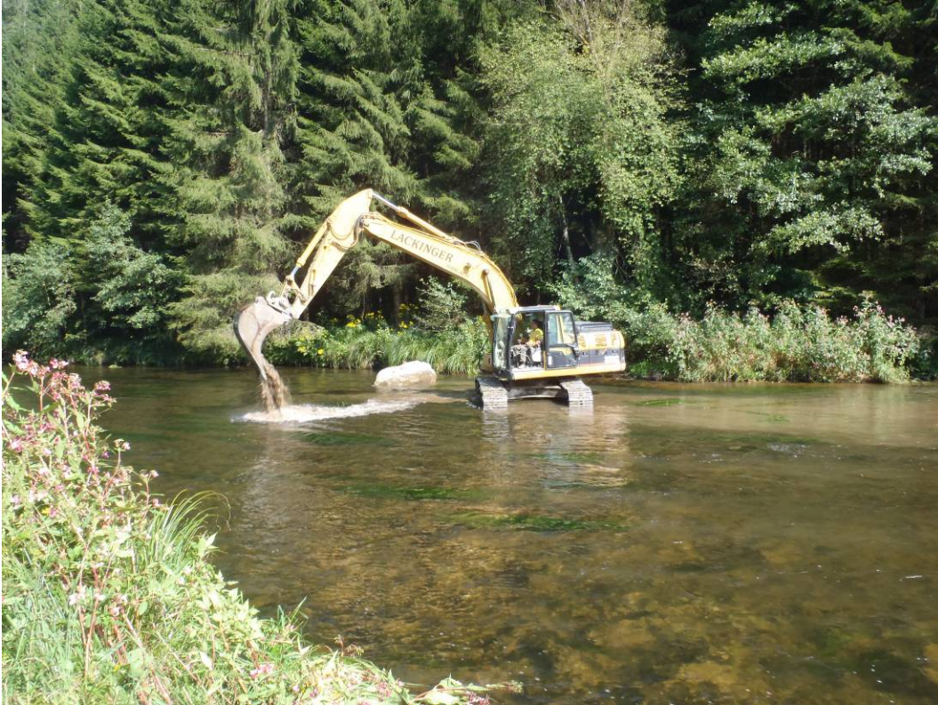
Abbildung 13. Partielle Entfernung der Deckschicht und Positionierung eines Granitblocks in der Untersuchungsstrecke 3 (Haslach).
