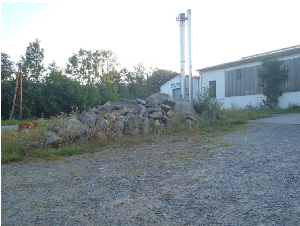
Abbildung 6. Granitblöcke die für die Umsetzung der Restrukturierung an der Gr. Mühl verwendet wurden (kostenlos zur Verfügung gestellt vom Stift Schlägl).
