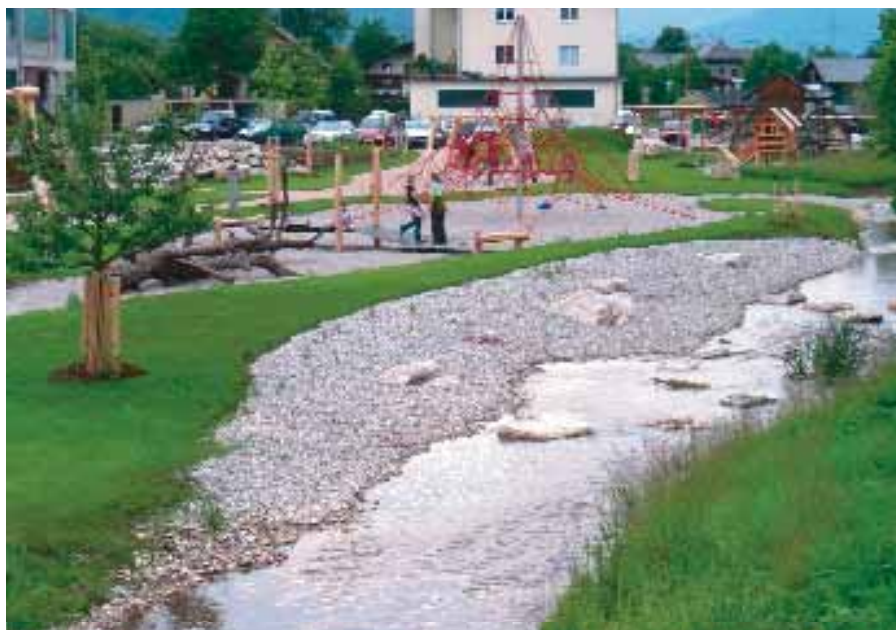
Der kanalartig eingeeengte Bach wurde aufgeweitet und mit einem flachen Schotterufer zum zentralen Teil des Bachspielplatzes.
