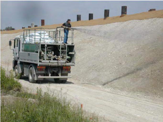
**Abb. 2:** Ausbringung des Saatgutes (Strohmulchsaat) im Anspritzverfahren ([www.hydrogreen.at](http://www.hydrogreen.at)). An der Hangschulter: Kosmatten gegen Erosionen. Juni 2005.
