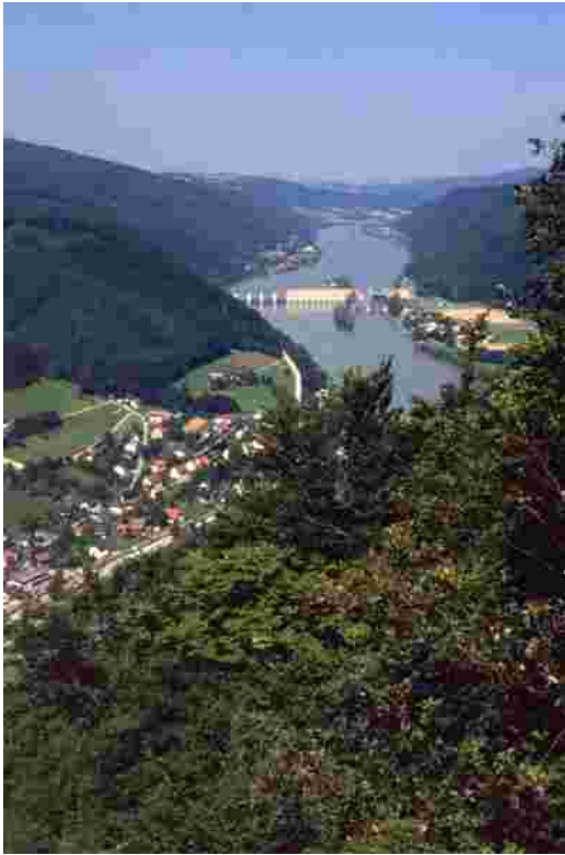
Foto 19001: Das aufgestaute obere Donautal mit dem Kraftwerk Jochenstein
