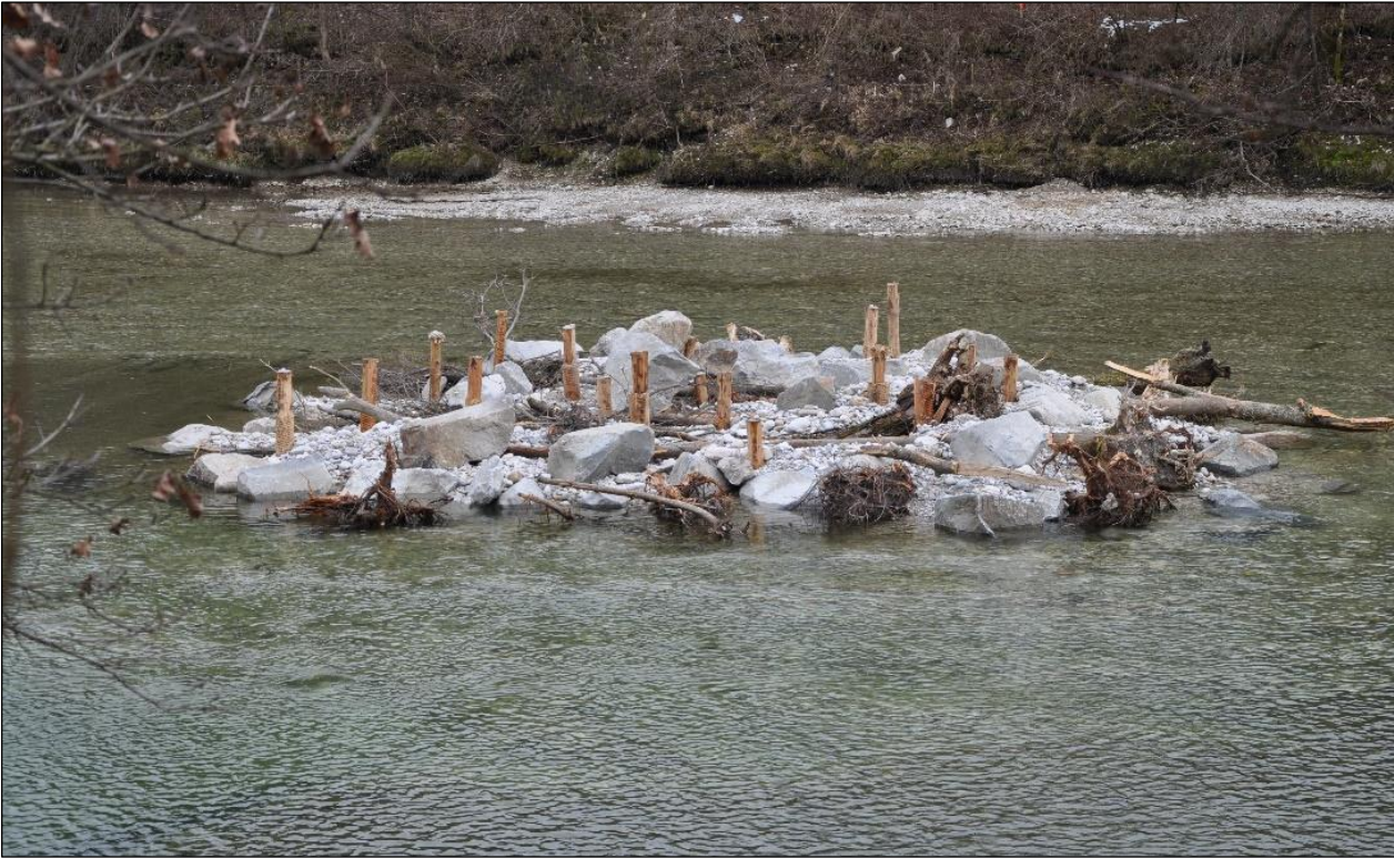
Abb. 21 Ein sogenannter Chevron in einer Restwasserstrecke der Traun.
