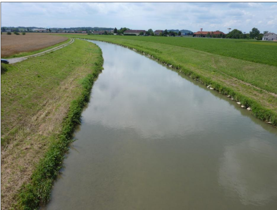
Abb. 19 Probestrecke 2 – regulierter Abschnitt der Krems flussauf der Straßenbrücke in Kremsdorf.
