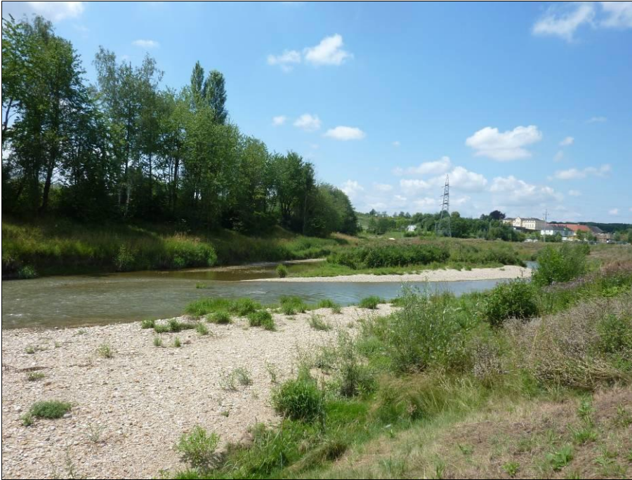
Abb. 3: Probestelle 1 nach erfolgter Restrukturierung.
