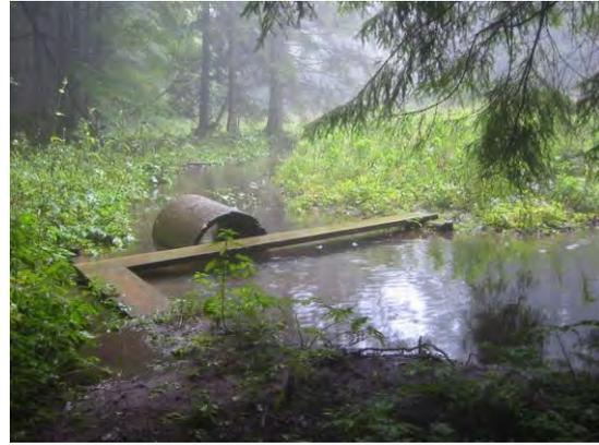
Abb. 13 / Abb. 14 Künstliche Staustufe mit Brettersteig und Betonrohr
