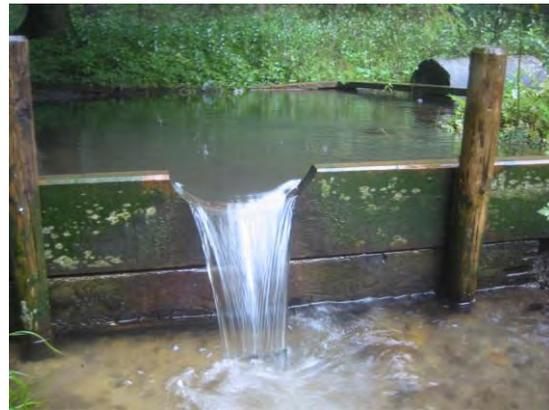
Abb. 15 / Abb. 16 Künstliche Staustufe mit Überlauf
