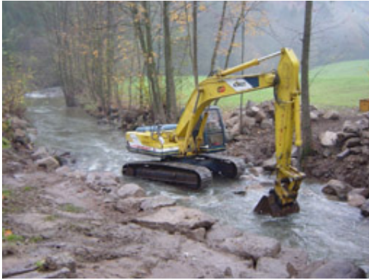
Abb. 34 (links): Bauarbeiten zur Wiederherstellung der Ufer nach dem Hochwasser (oberhalb von P24; Oktober 2002)
