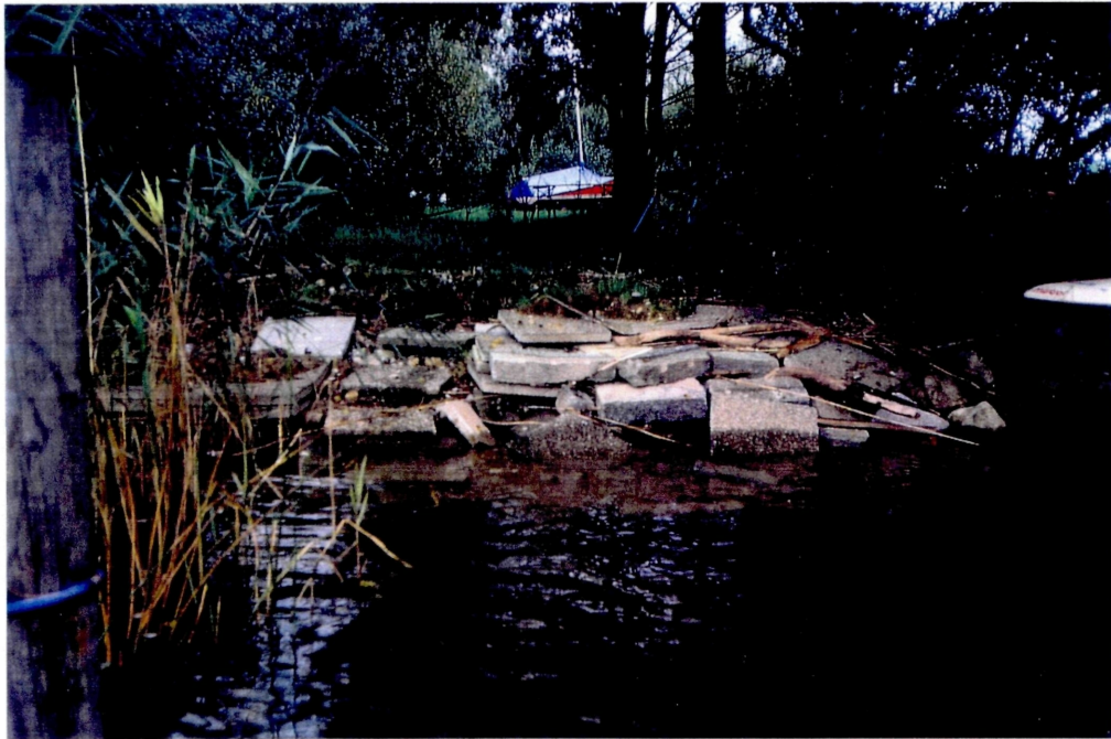
Abb.3 : Neu entstandene Uferbefestigung am südlichen Rand des Schutzzaunes, Schilffläche S
