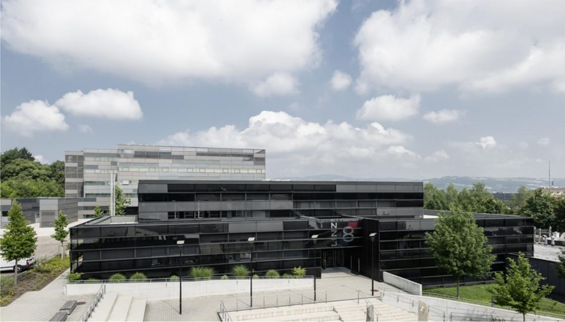
Auf die vorhandene Stahlbetonstruktur des Internatsgebäudes wurden ein viertes Wohngeschoss sowie ein atriumartiger »Open Space« im Dachgeschoss aufgesetzt.
