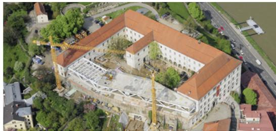
Hinter dem geschlossenen Baukörper verbirgt sich eine atemberaubende Stahlkonstruktion, die semantisch passend die Technikausstellung beherbergt.
