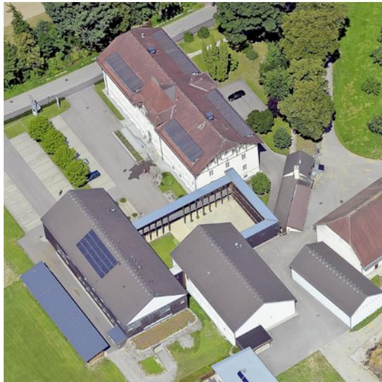
Zwei bestehende Pavillons wurden aufgestockt, verlängert und mit neuen Satteldächern eingedeckt. Deren Neigung und Firstrichtung sind nun auf den Bestand abgestimmt, was wesentlich zur maßstäblichen Korrektur der Anlage beiträgt.
