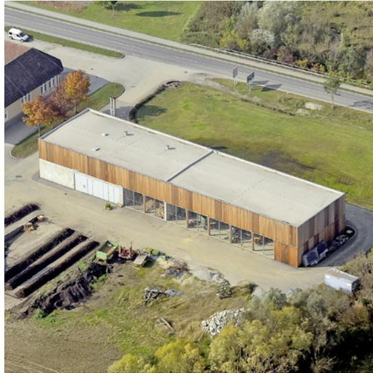
Die Holzkonstruktion folgt einem strengen, am Gebäude gut ablesbaren Raster. Alle Holzaußenwände sind aus Elementen einer einzigen Größe (1,70 x 4,35 Meter) zusammengesetzt.
