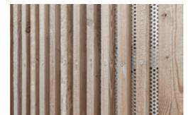
Belichtung und Belüftung erfolgen durch eine Lamellenstruktur, die mit Plexiglas beziehungsweise Lochblech hinterlegt ist.
