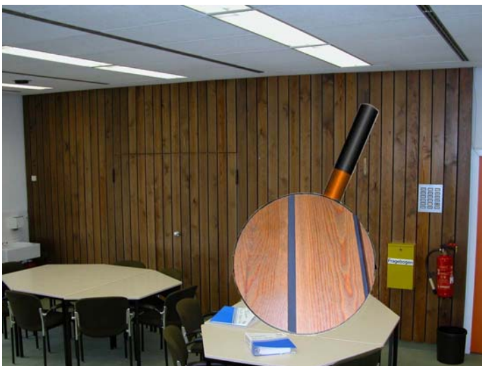
Abb. 13 Schallabsorber aus Holzriemen mit Luftspalten
