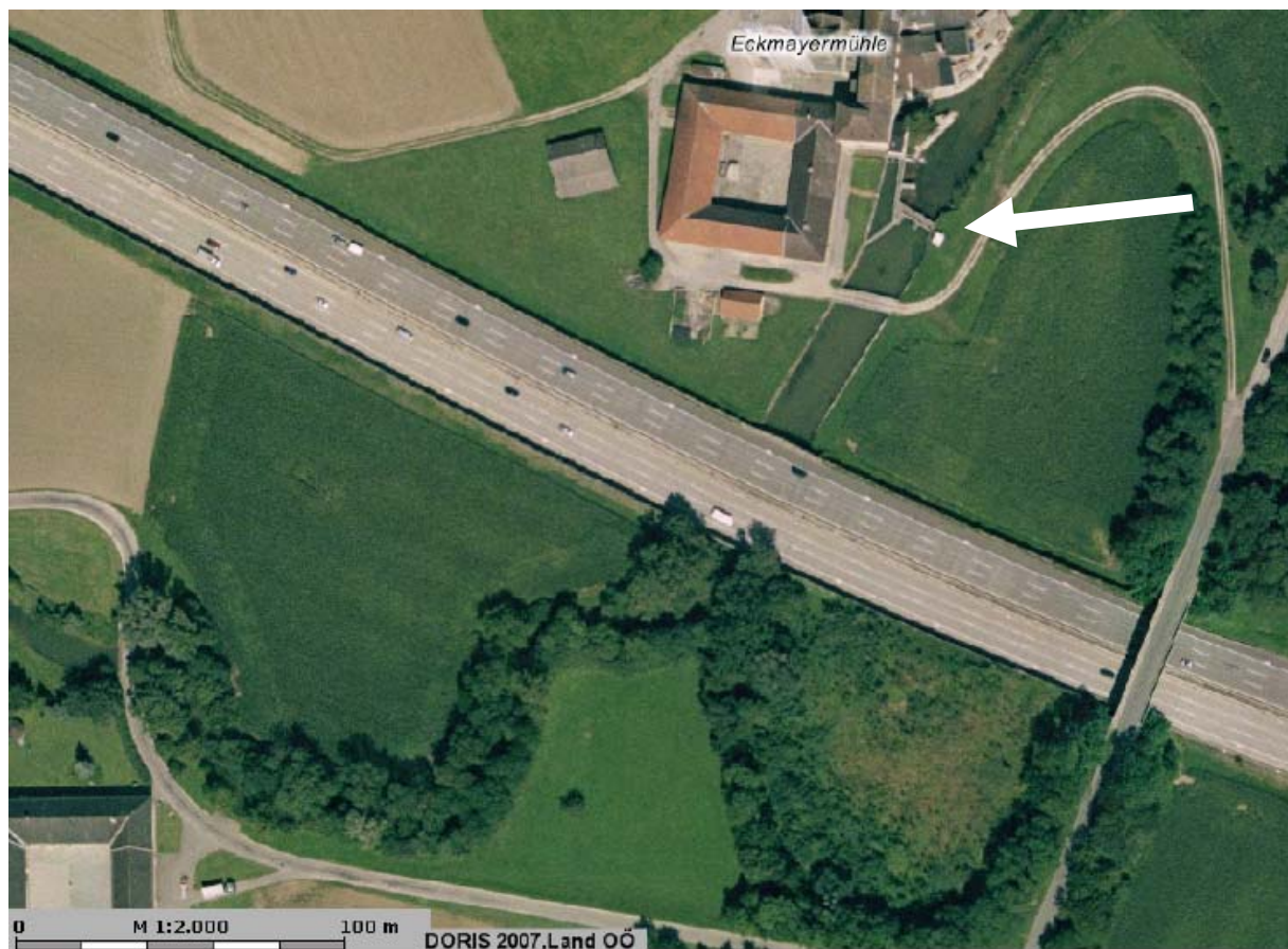
Abbildung 3: Messstation Eckmayrmühle S171
