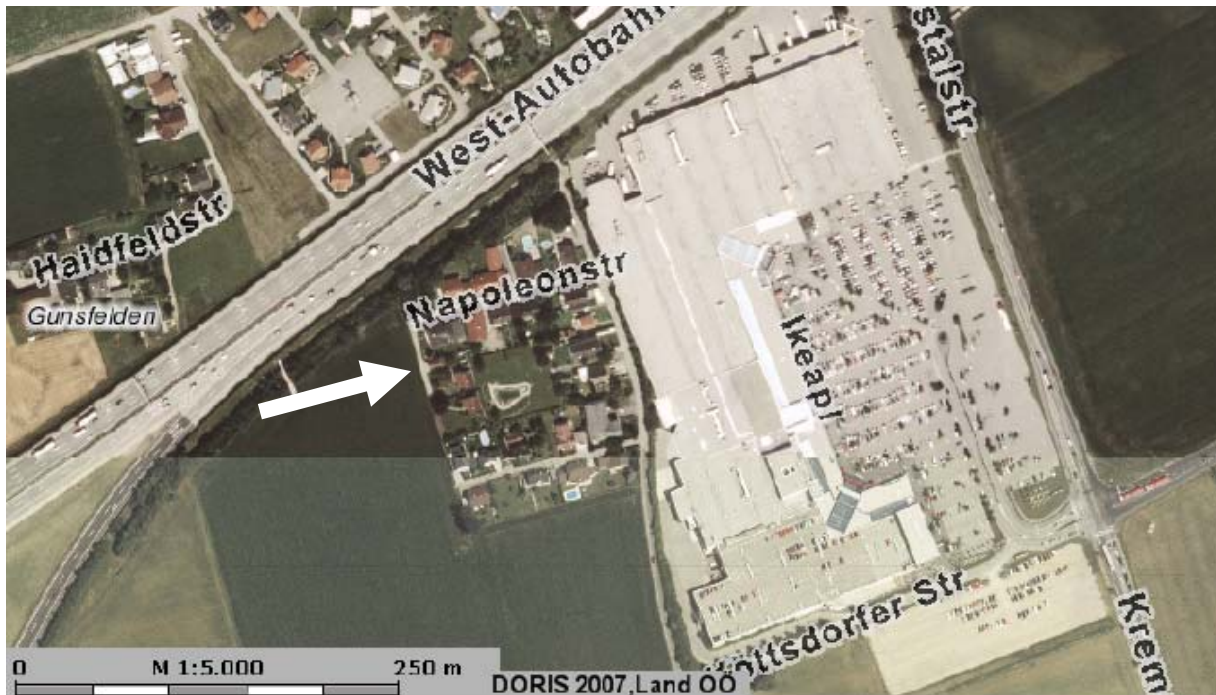
Abbildung 4: Messstation Haid-Napoleonsiedlung S176
