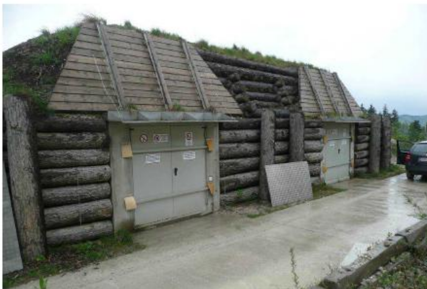
Sprengmittelmagazine auf der Seehöhe von ca. 670 m ü.A.
