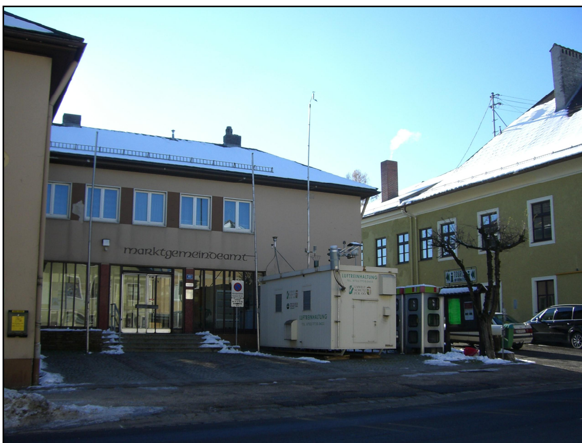
Abbildung 4: Messstelle S178, in südwestlicher Richtung
