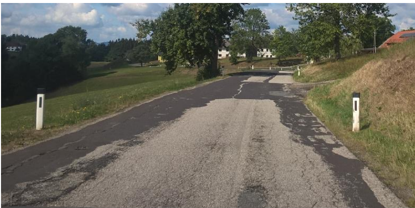
Abbildung: desolater Straßenzustand und unzureichender Fahrbahnquerschnitt
