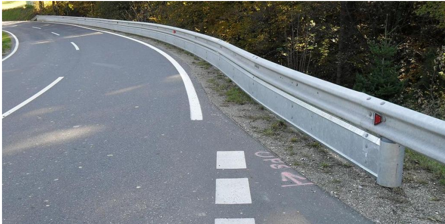
Abbildung 11: Beispiel einer Motorrad-Leitschienen-Unterschutz Verbauung (Quelle Land OÖ)
