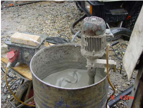
Abbildung 9, Anmischen der Suspension mit Rührwerk
