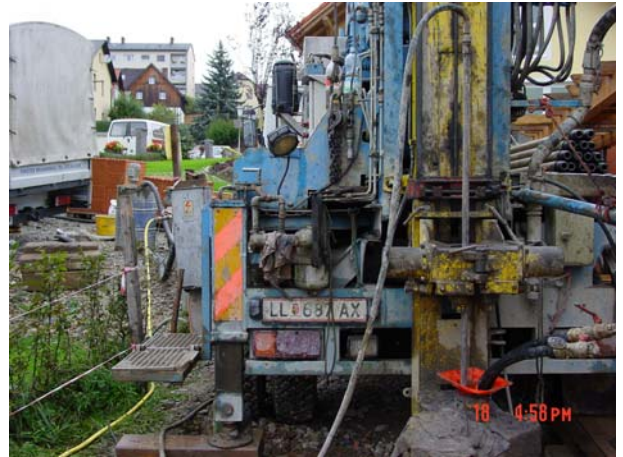
Abbildung 10, Verpressung mittels Verpressgestänge
