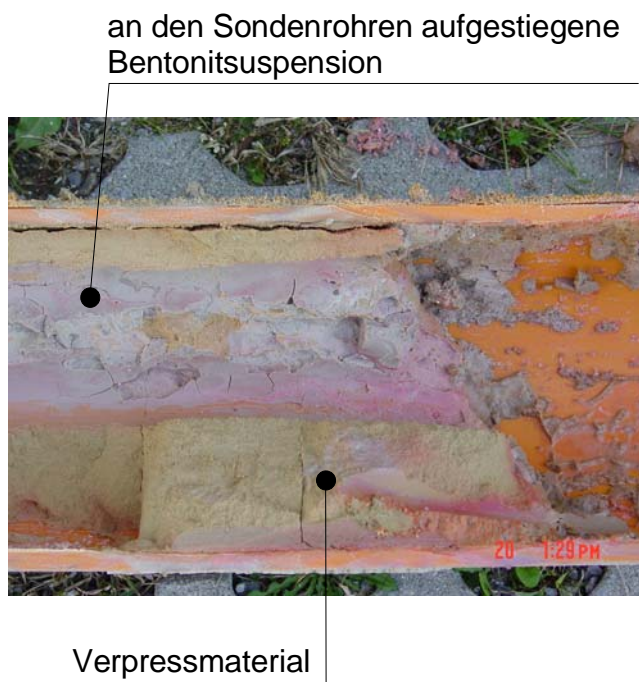
Abbildung 46, Verpresskörper 5, Detail Bereich Sondenverrohrung
