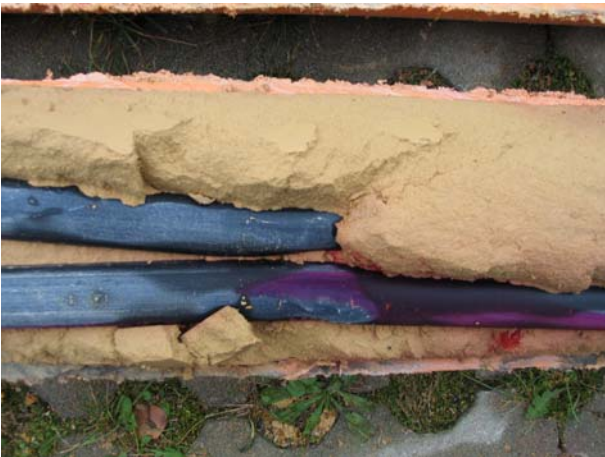
Abbildung 29, Detail Anlagerung Tracer an Sondenrohren
