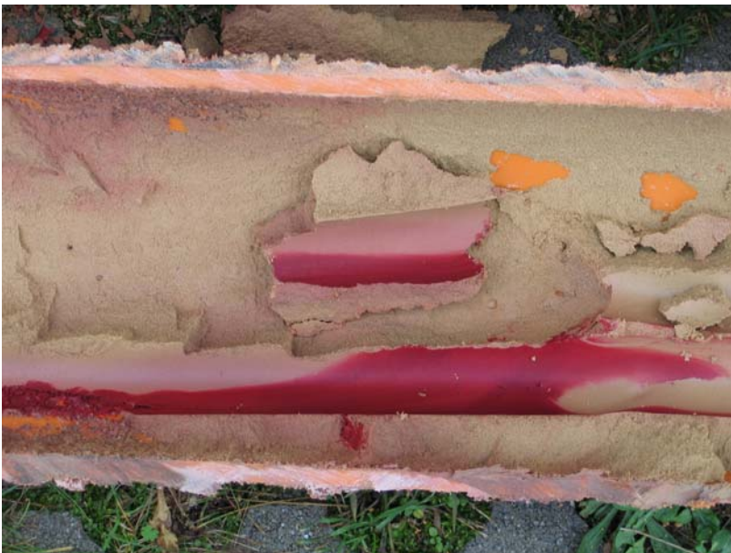
Abbildung 43, Anlagerung des Fartracers im Bereich der Sondenverrohrung bei Verpresskörper 4
