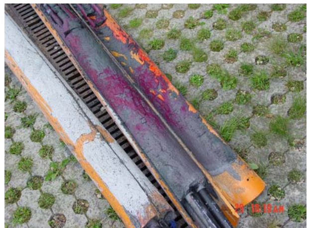
Abbildung 20, Tracerablagerung an Grenzfläche zum Außenrohr
