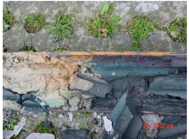
Abbildung 24, Detail Übergang Suspension- Bentonit
