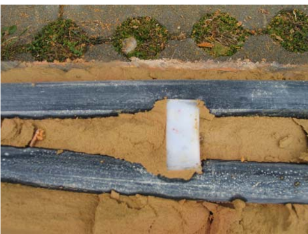
Abbildung 31, Detail Umhüllung Abstandhalter
