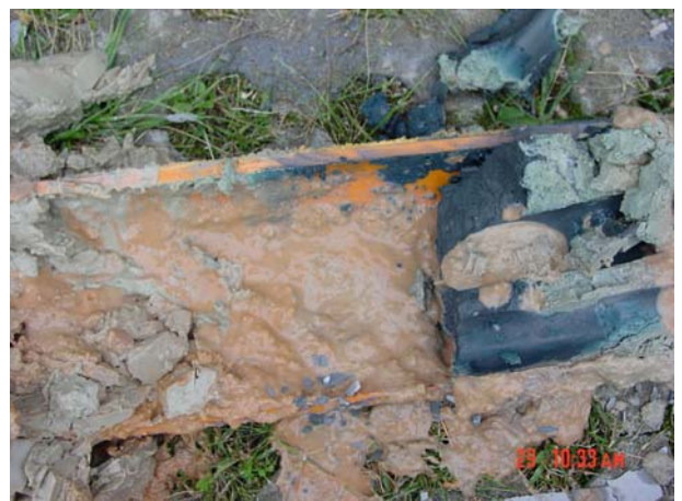
Abbildung 26, Detail Einschluss Bohrspülung
