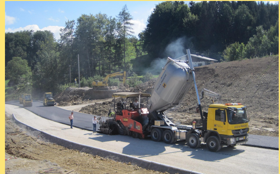
(Abb.: Asphaltierungsarbeiten)
