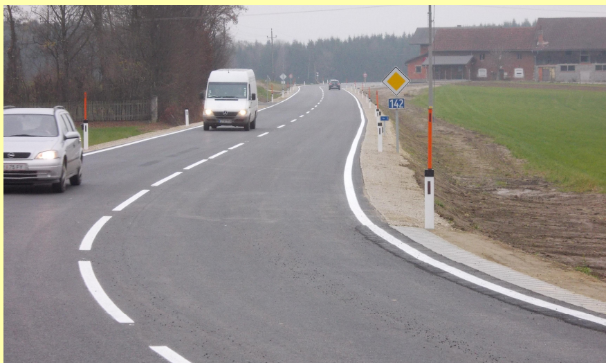
Abb.: (November 2014 – neuausgebautes Straßenstück)
