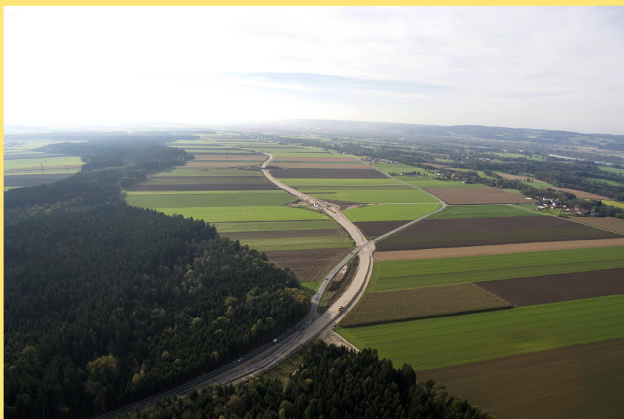
(Abb.: Blick auf die neue Trasse der Umfahrung St. Peter – Oktober 2014)
