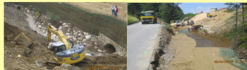
(Abb.: Herstellung Bewehrte Erde)
