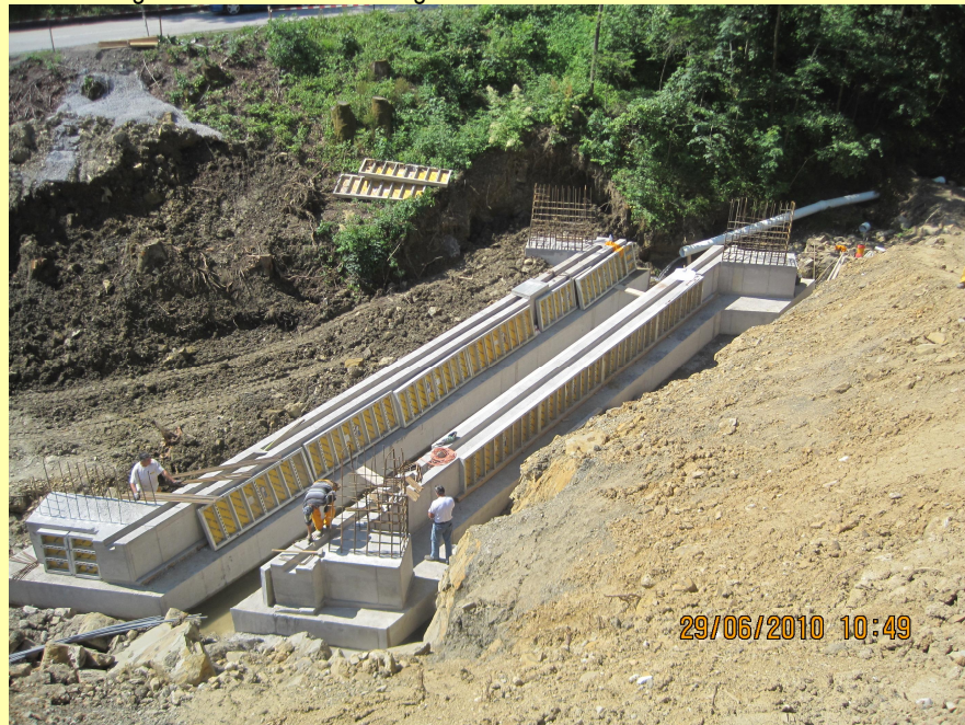
(Abb.: Durchlass Bergbauerngrabenbach)
