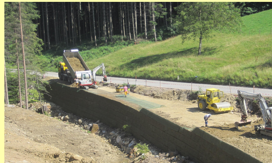
(Abb.: Herstellung Bewehrte Erde)
