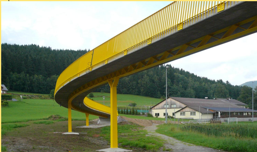
(Abb.: Geh- und Radwegbrücke)
