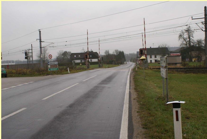
(Abb.: ehemaliger Bahnübergang)
