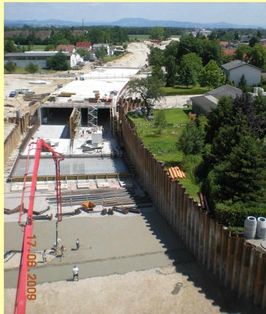
(Abb.: Betonierarbeiten im Bereich der Grünbrücke)
